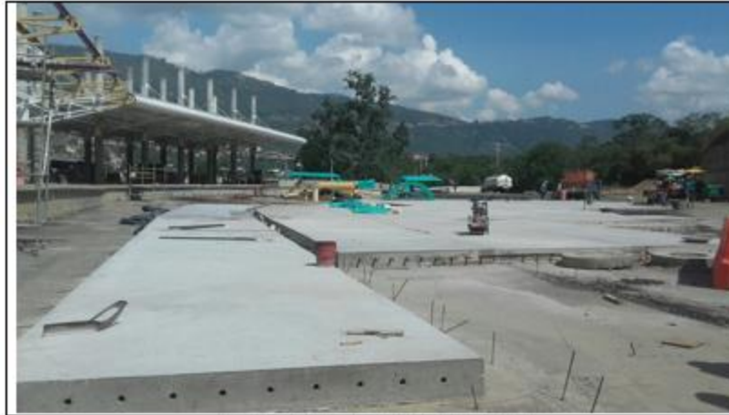
Construcción de Pavimento Rígido (MR)
