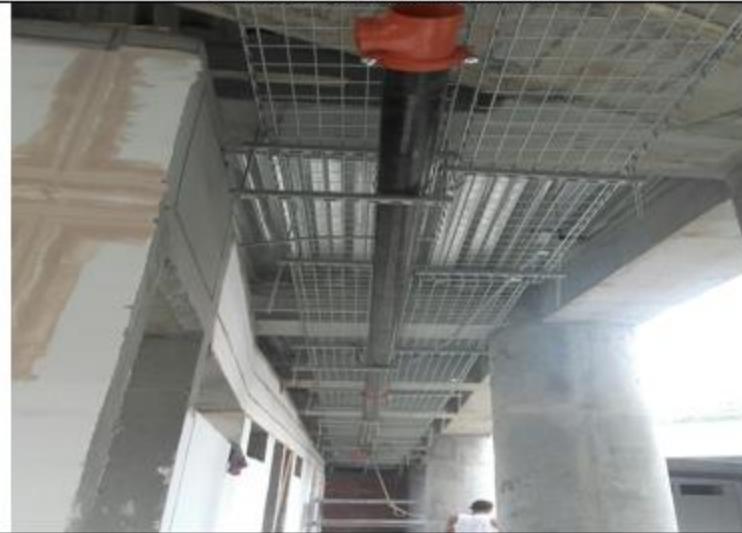
Instalación de Bandejas Portables y Tubería Contraincendio
