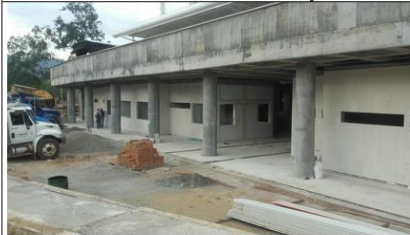
Instalación de Enchapes y Acabados
