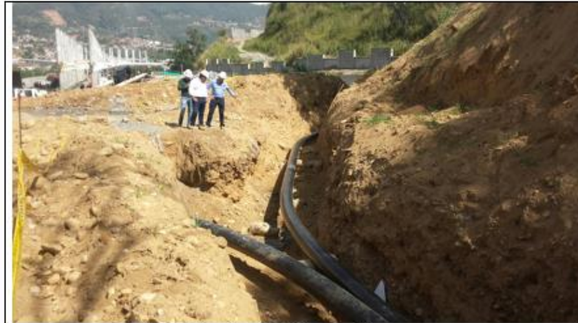
Traslado línea Gasoducto Gibraltar - Bucaramanga
