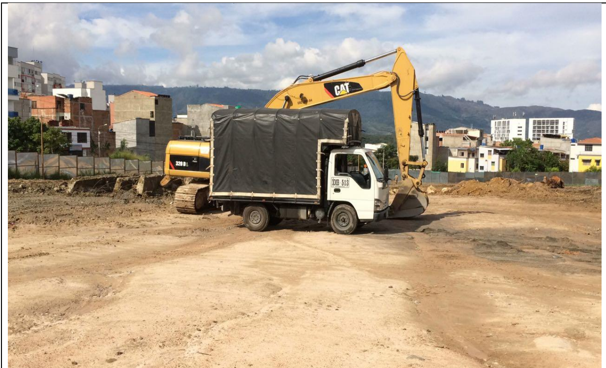
Obras de excavación y replanteo
