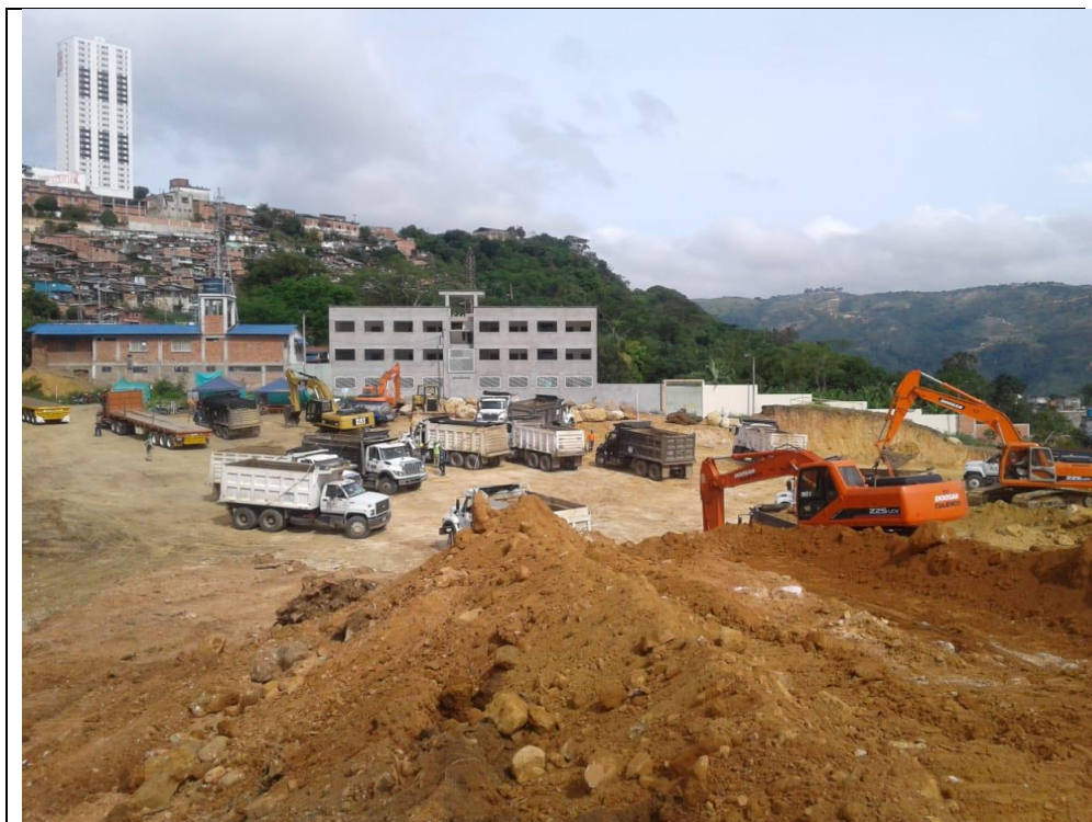
OBRAS DE EXCAVACION
