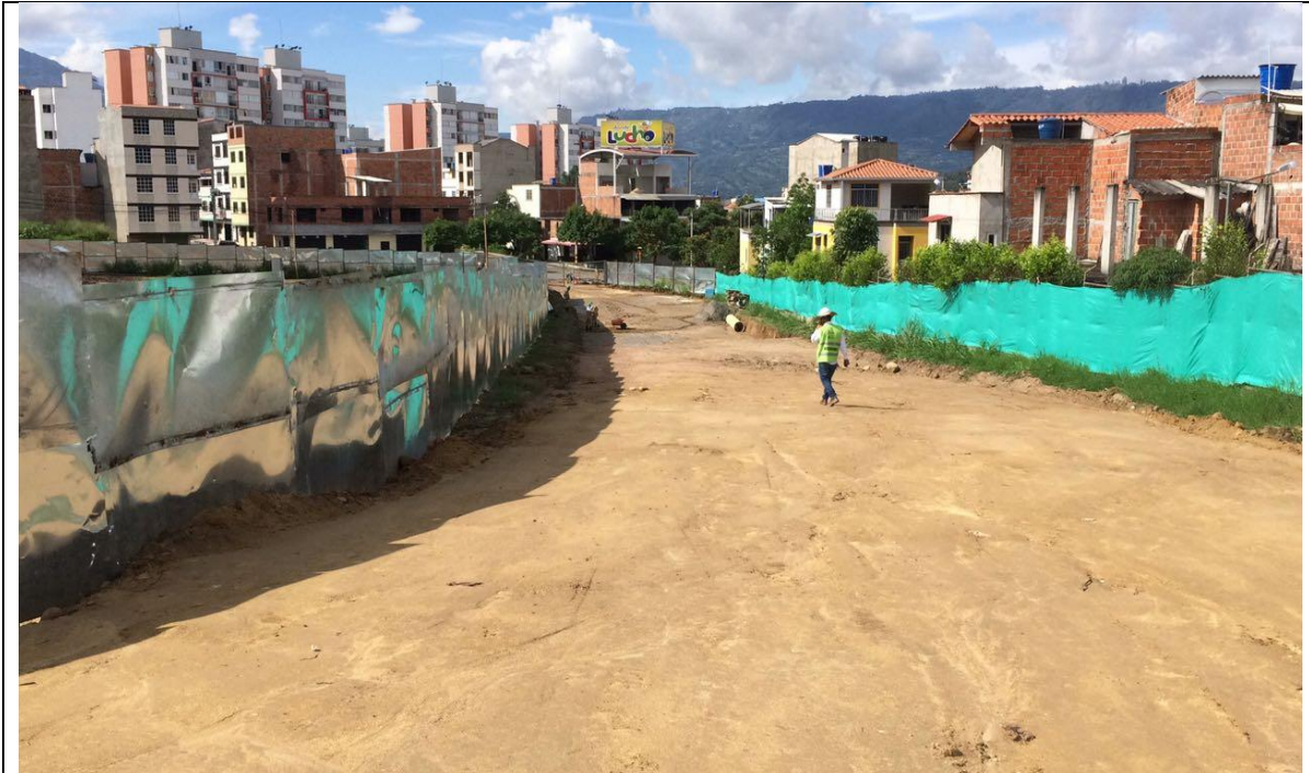
Construcción vía carrera 4ta
