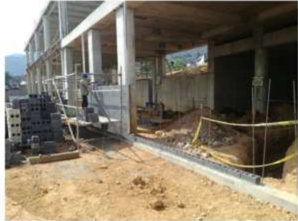
Avance general de acceso placa túnel que comunica las plataformas norte y sur
