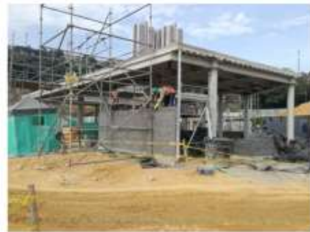
Construcción de oficinas Operativas patio taller
