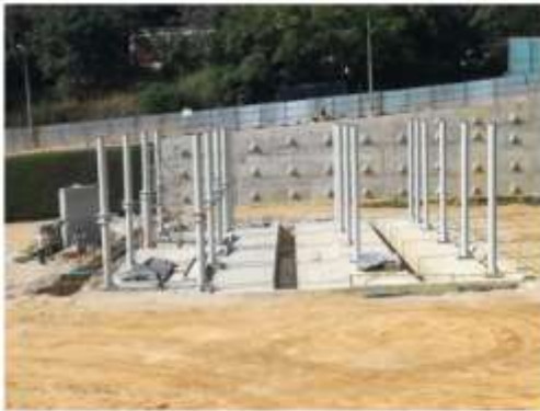
Instalación de estructura metálica en edificio de mantenimiento Patio Taller
