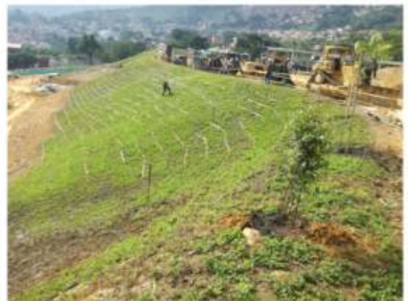
Estabilización de talud central con material vegetal
