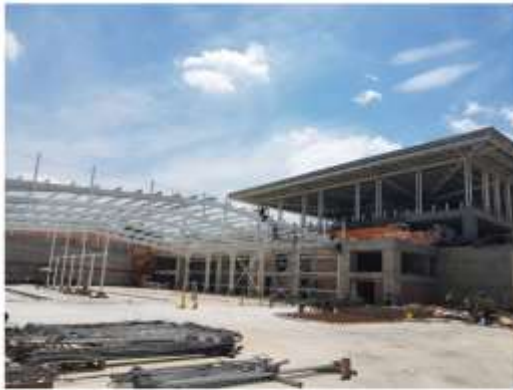
Vista Interior avance de obra zona de mantenimiento y costado occidental zona de transferencia
