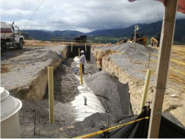
Instalación de tanques de almacenamiento de combustible
