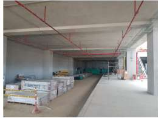
Instalación de redes contraincendio bajo placa zona de transferencia troncales
