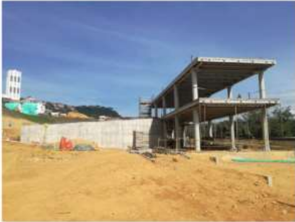
Avance general de estructura equipamiento localizado en estación de transferencia
