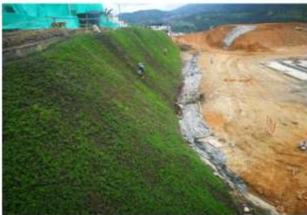
Aspecto final de estabilización de talud con anclajes pasivos
