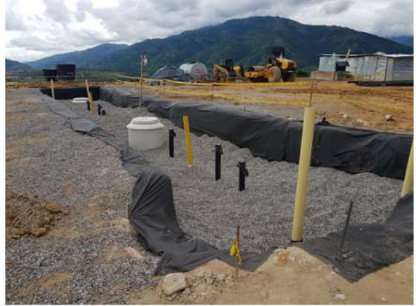
Instalación de tanques de almacenamiento de combustible
