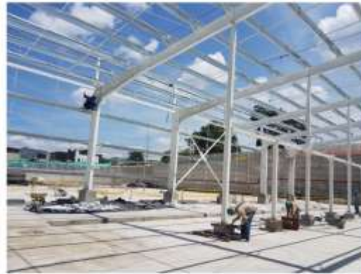
Construcción de cubierta metálica zona de mantenimiento
