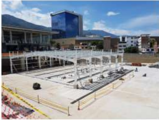
Panoramica avance zona de mantenimiento, cárcamos y cubierta
