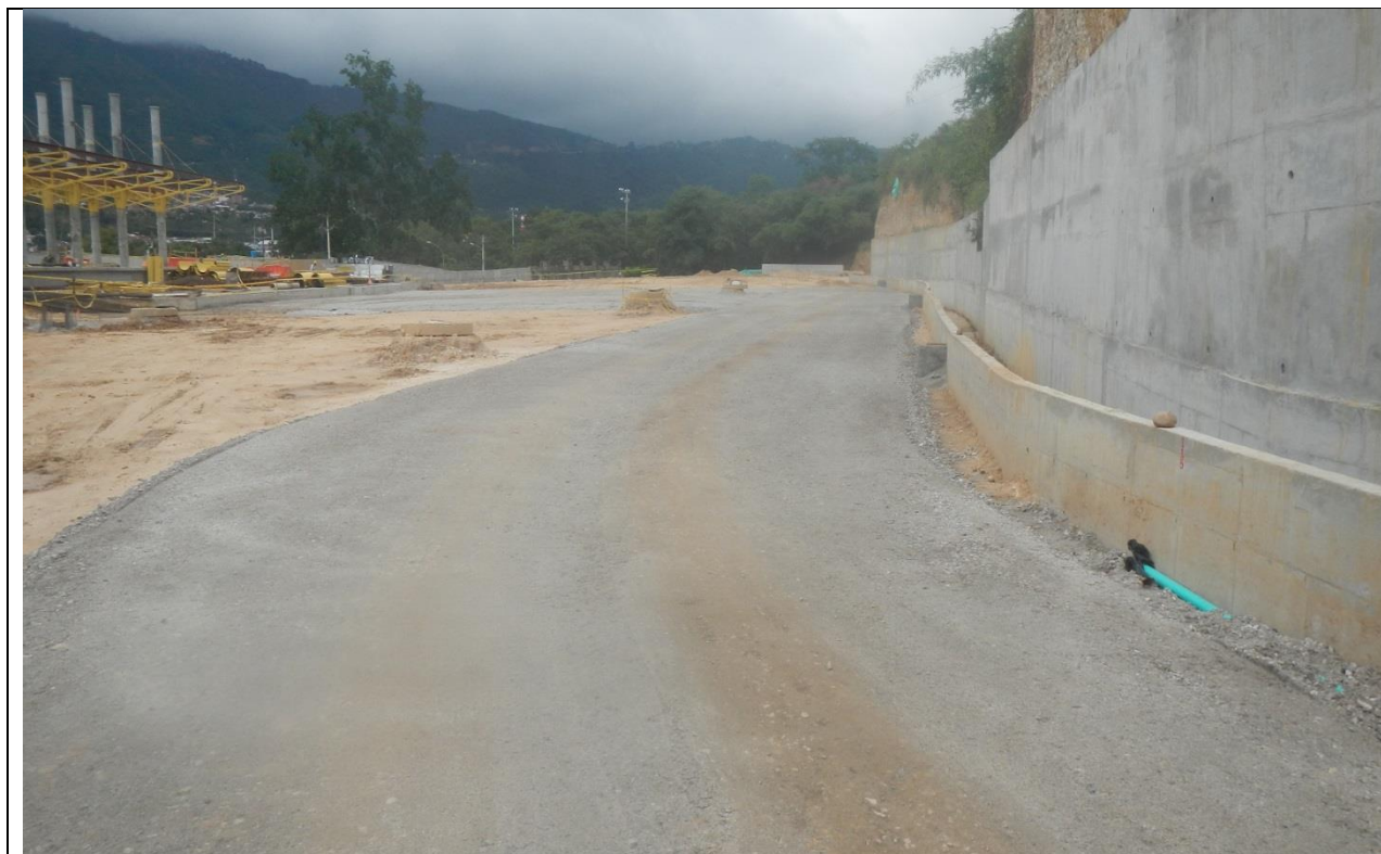
Conformación de base para pavimentos Patio de Parqueadero
