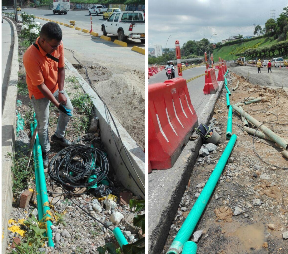
Imagen: Tendido 400 mts de ducteria y fibra
