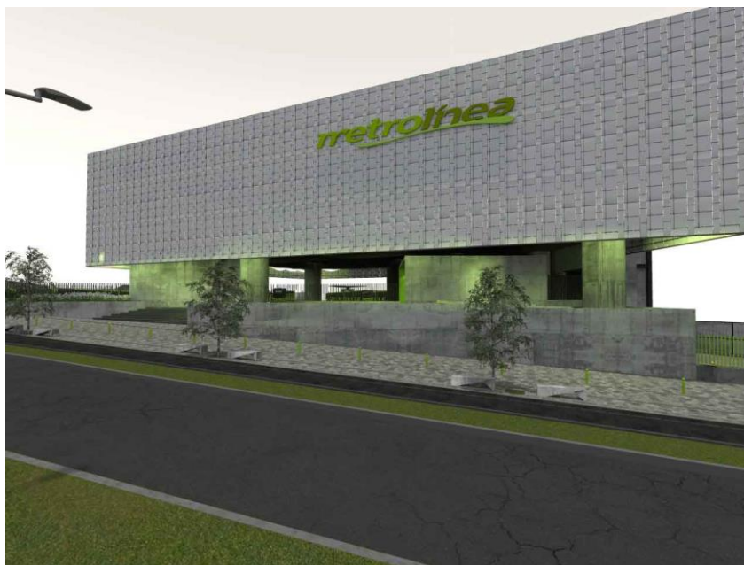
Fachada lateral bloque de oficinas administrativas
