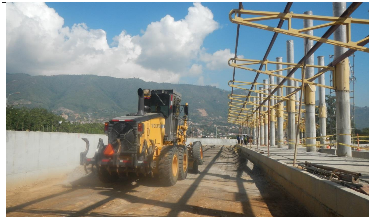
Cubierta Metálica y conformación de base para Pavimentos
