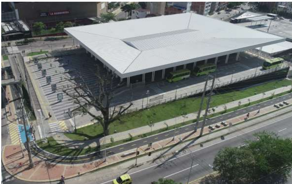
Terminación de estación de transferencia
