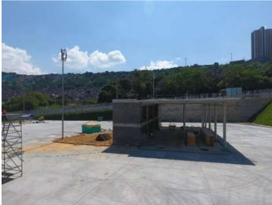
Construcción de zona de mantenimiento
