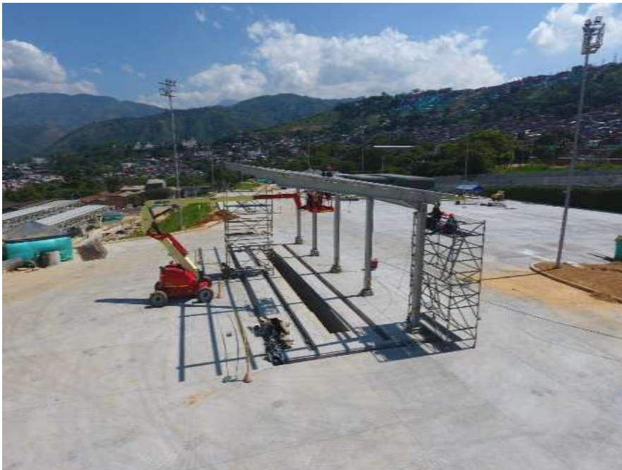
Construcción de cubierta en estructura metálica para zona de lavada de buses
