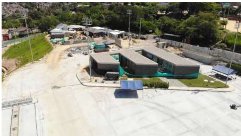
Construcción de oficinas administrativas patio Taller
