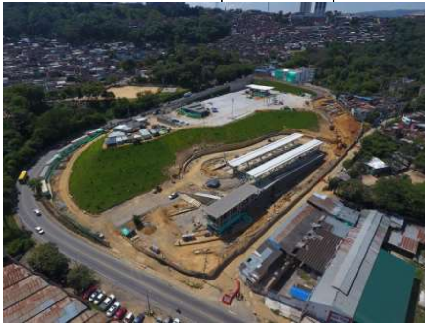
Vista Panorámica avance de obra - zona alta patio taller - zona baja estación de transferencia
