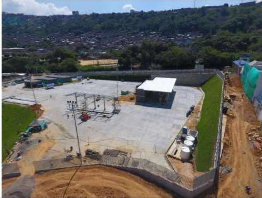
Construcción de cerramiento perimetral sector patio taller
