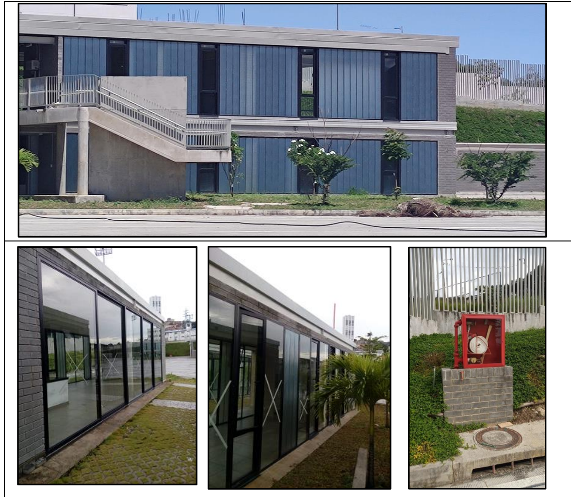
Ilustración 25, Reparaciones en las oficinas del patio taller, garita y cerramiento en el marco del contrato No. 102 de 2022
