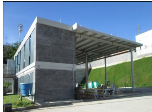
Ilustración 17, Zona de patio taller
