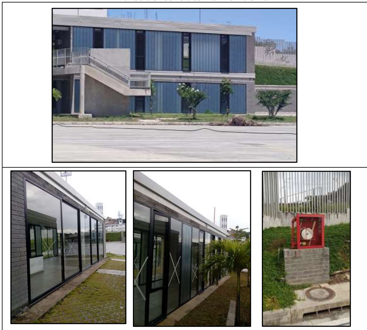
Imagen 13 Reparaciones en las oficinas del patio taller, garita y cerramiento en el marco del contrato No. 102 de 2022
