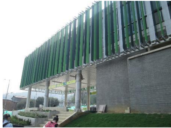
ZONA DE ACCESO CALLE 7N
