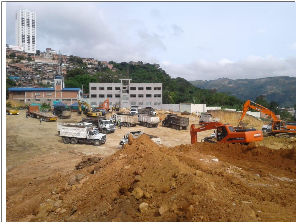
OBRAS DE EXCAVACION
