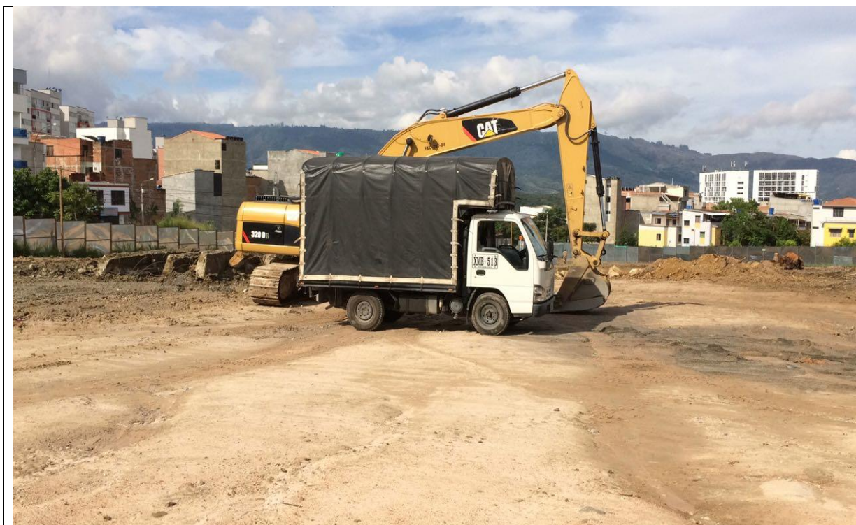
Obras de excavación y replanteo
