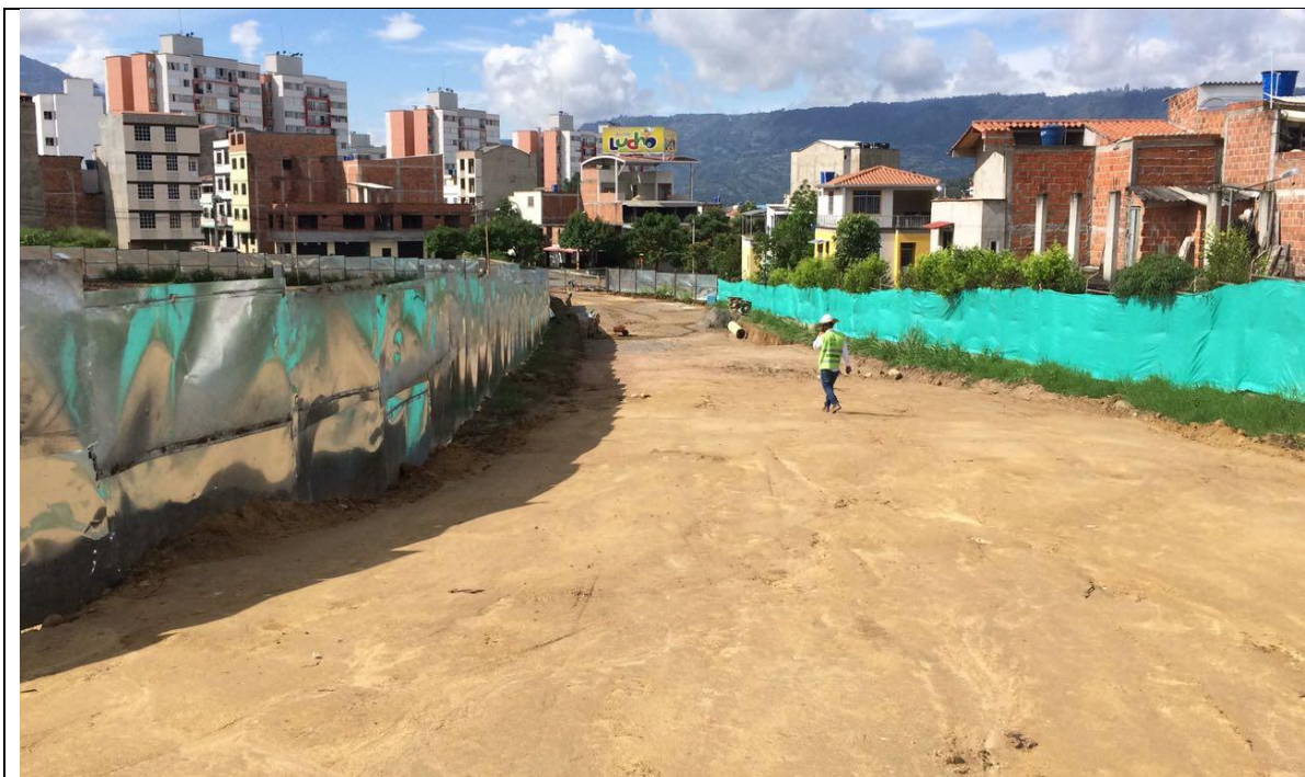
Construcción vía carrera 4ta
