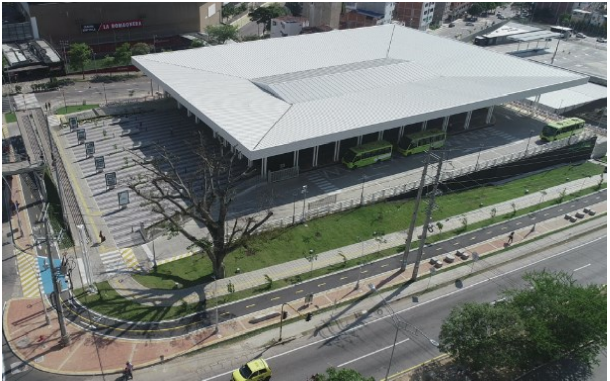
Estación de Transferencia en Operación.
