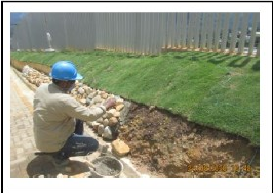
INSTALACION DE ACABADO EN ROCAS PARA PATA TALUD ANGELES CUSTODIOS www.bucaramanga.gov.co
