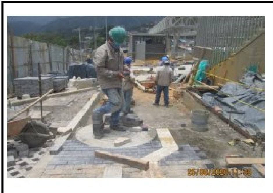
INSTALACION ADOQUIN CALLE 7N
