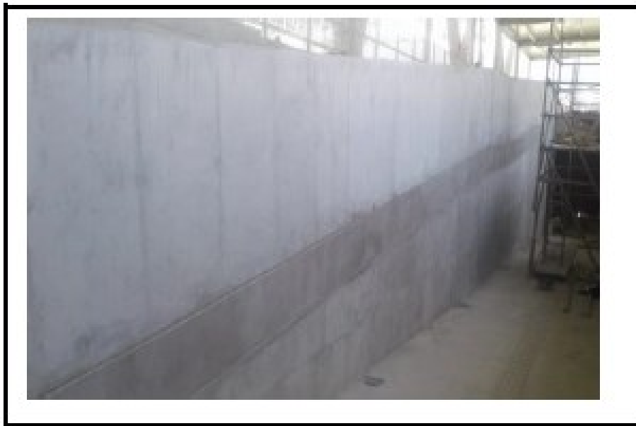
ACABADOS Y RESANES MURO ESCALERAS DE ACCESO A PLATAFORMAS
