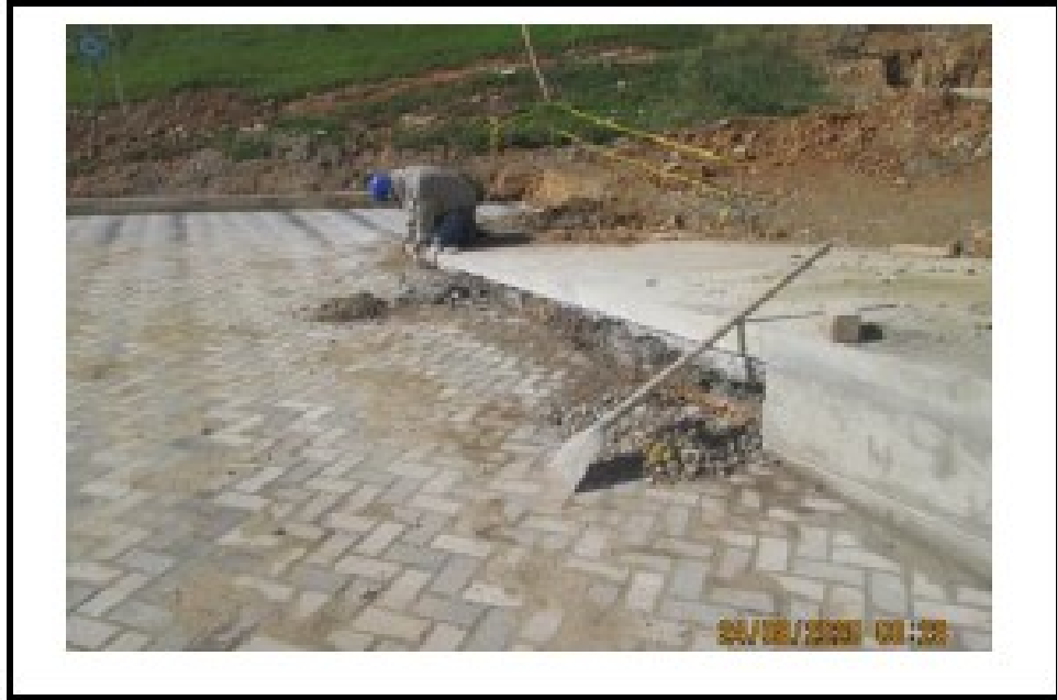
ACABADO DE EMPALME ENTRE TRAMPA DE ACCESO Y ADOQUIN PLAZOLETA DE ACCESO
