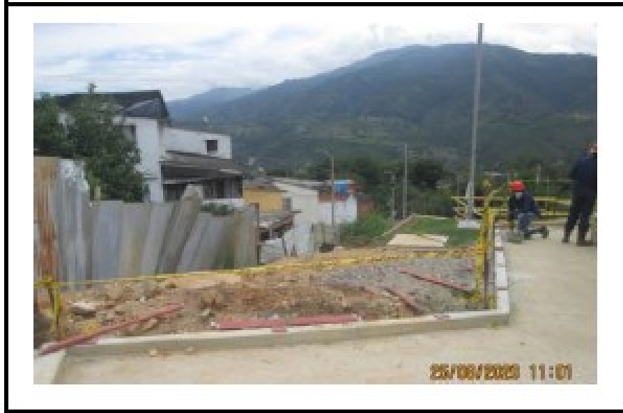
INSTALACIÓN DE BARANDAS PARA RAMPAS MIRAMAR
